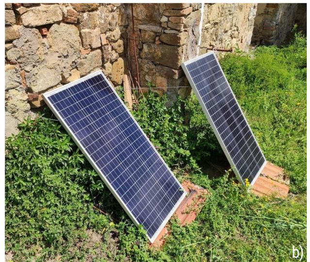
Figura 2.8. (a) Stazione MALA0 (vedi anche Figura 2.11) installato all'interno del fabbricato, che ospita anche il router 4G per la trasmissione dati di tutto l'array. (b) Pannelli solari per l'alimentazione del router e della stazione sismica.
